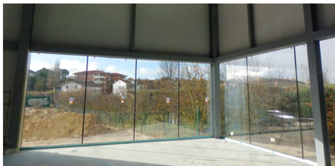
Detalle del acristalamiento desde el interior
